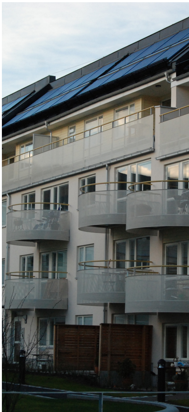
Hamnhuset, lågenergiprojekt. Byggherre Älvstranden Utveckling. Foto: Paula Femenías
