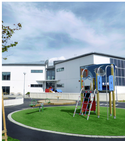
Transistorgatans förskola. Lågenergiprojekt av Lokalförvaltningen i Göteborg.
