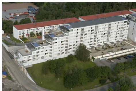
Figur X. Terrasshus i Gårdsten. www.samhallsbyggardagen.se/s25095
